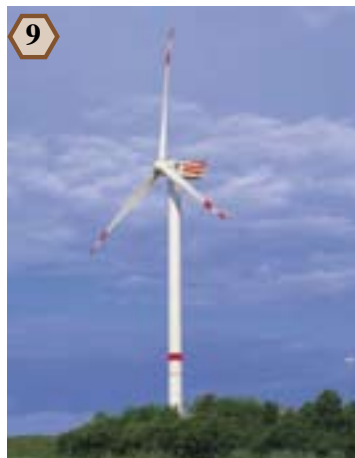
9 Cette éolienne de 5 MW pourrait fournir l'électricité nécessaire à 15 000 habitants pour alimenter leurs véhicules électriques hybrides, en utilisant un peu de biocarburant, sans essence ni diesel (photo gracieuseté de RePower Systems AG).
